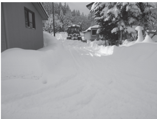
村道沢無平1号線ローダ除雪状況
